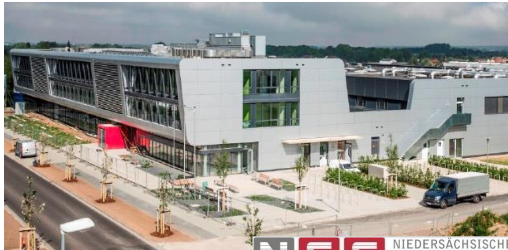
Bürogebäude Hermann-Blenk-Str. 42 Prüfstände Elektroantriebe Labor Leistungselektronik Büros
