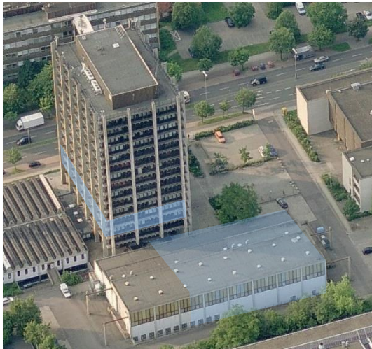
Bürogebäude Hans-Sommer-Str. 66 Maschinenhalle Labor Leistungselektronik Werkstatt
