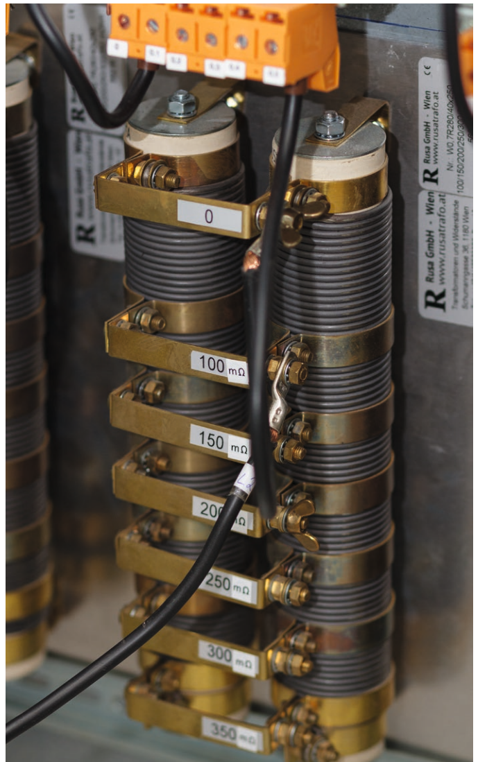
Leitungsnachbildende Elemente entsprechen bis zu 1,8 km Niederspannungskabel
