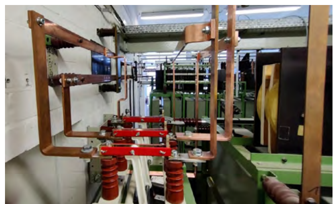
Montage eines 6kV Trenners und Anschluss durch Kupferschienen
