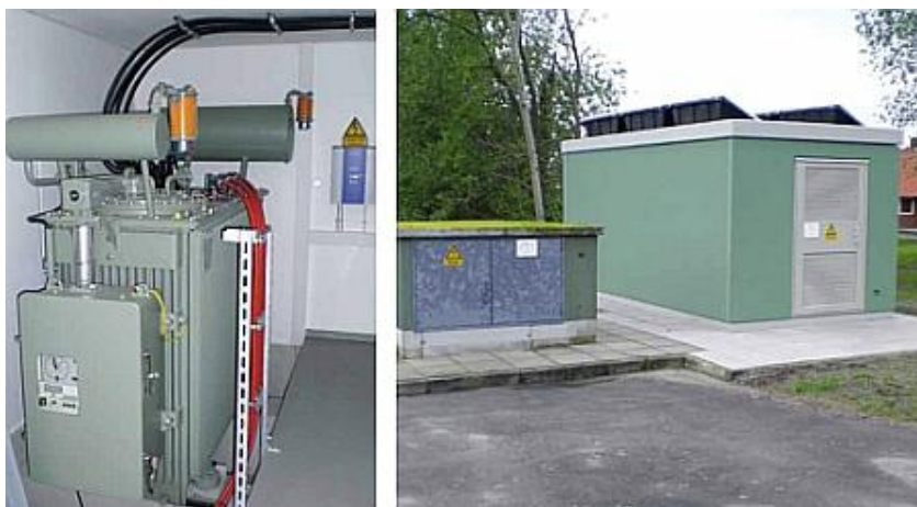
Abbildung 1: Regelbarer Ortsnetztransformator
