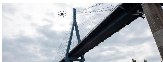
Abb. 10: Drohne bei der Inspektion einer Hochbrücke, DLR
