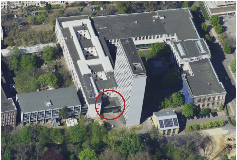
ABB. 2: LUFTBILD OKERHOCHHAUS, TU BRAUNSCHWEIG
