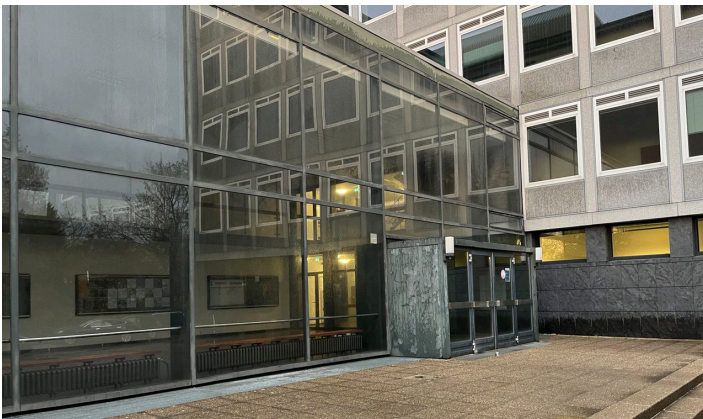
ABB. 4: AUSSENBILD FOYER OKERHOCHHAUS, ALIAS „AQUARIUM“ Quelle: IBEA, TU BS
