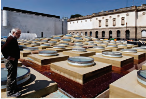
Bild 2-6 Oberlichter nach der Montage eingehüllt in eine Schutzkonstruktion © Kirsten Bucher
